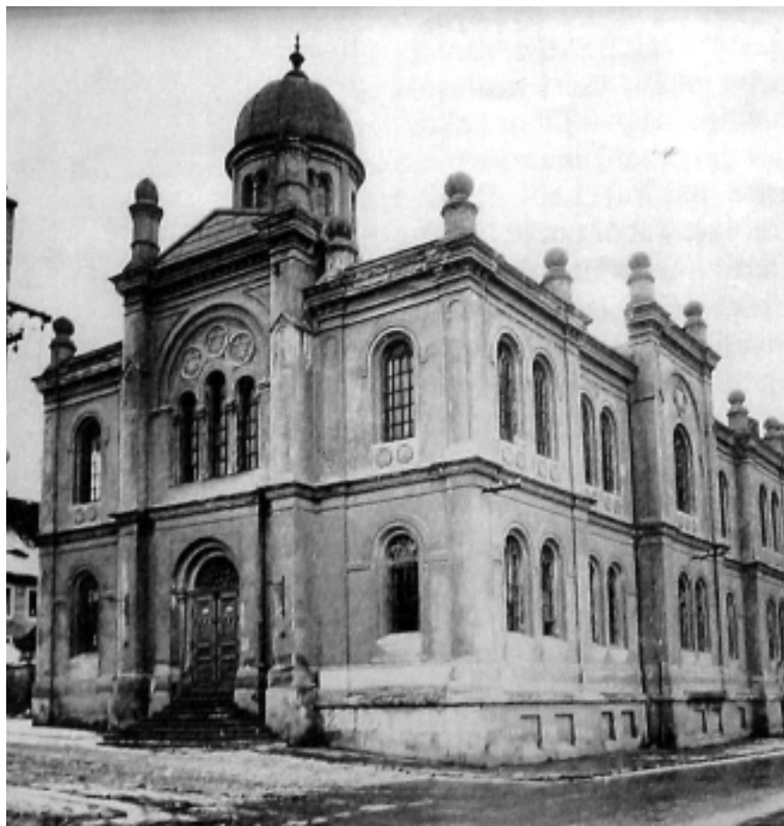
Průčelí tábořské synagogy z jihozápadu - Synagoga přečkala nacistické ničení a byla zničena (v solidním stavu) až v roce 1977 (Foto Rudolf Schlee, kolem roku 1935)
